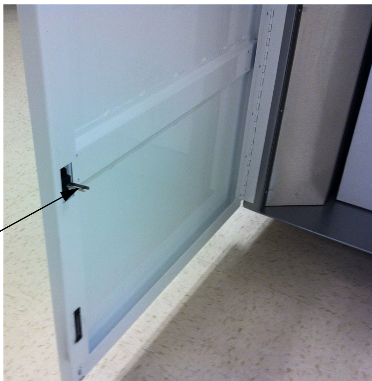
図 9-46. 廃棄物コンテナドアの金属ラッチ
